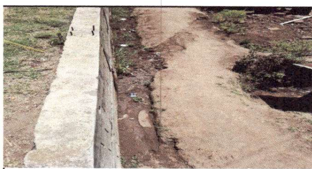
Foto 6: Sustrucción de baranda de metal.
