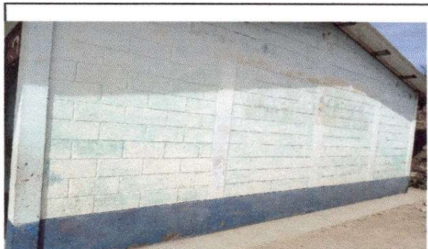
Foto 3: Pintura en muros exteriores e interiores
