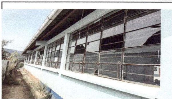
Foto 1: Sustrucción de Vidrios
